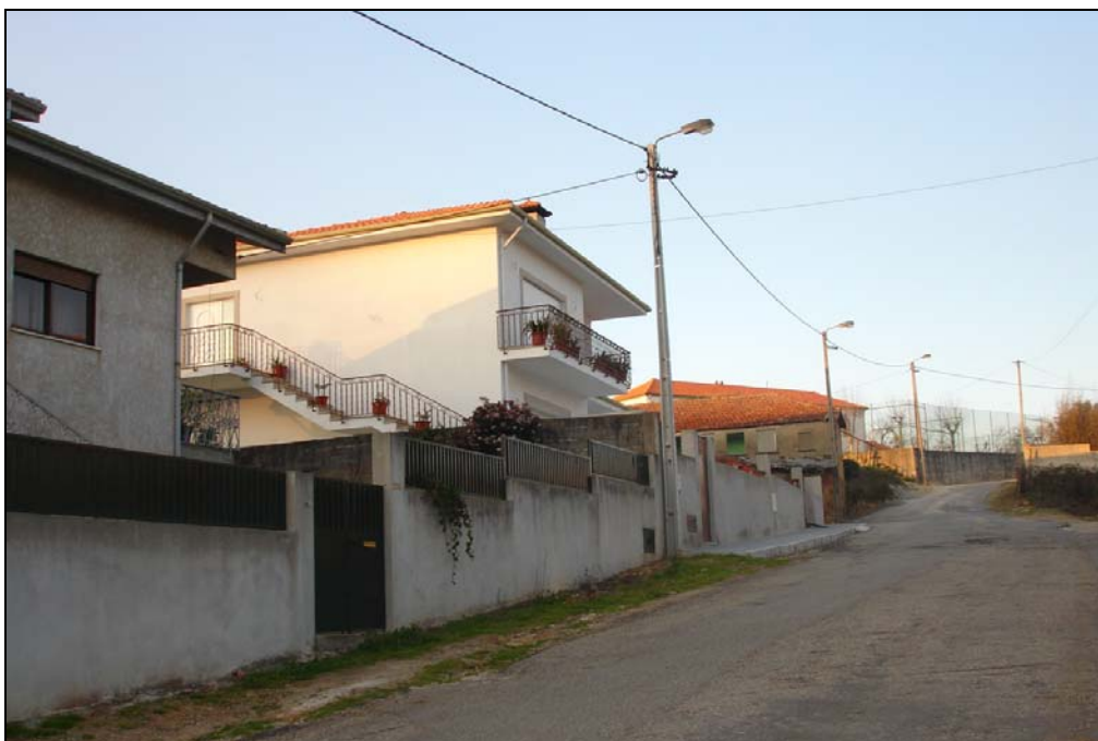
Fotografia 4.10.3 – Área Urbana na zona inicial do traçado (Aprox. ao km 1+500)
